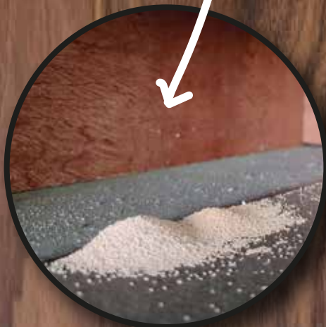
Acumulación de gránulos fecales indicativo de la no presencia de termitas subterráneas.
